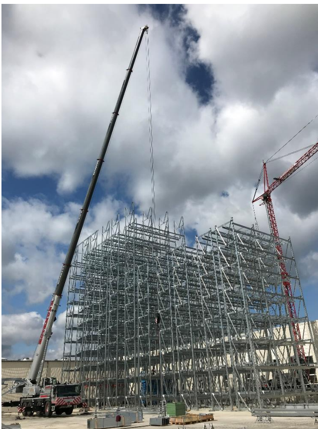
Für das neue Hochregallager werden insgesamt 1.600 Tonnen Stahl verbaut.
