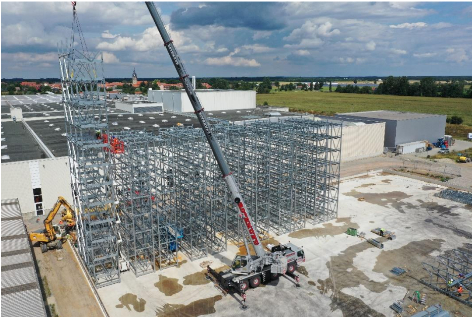
Auf der Baustelle in Calvörde geht beim Hochregallager voran - die ersten 10 Prozent stehen.
